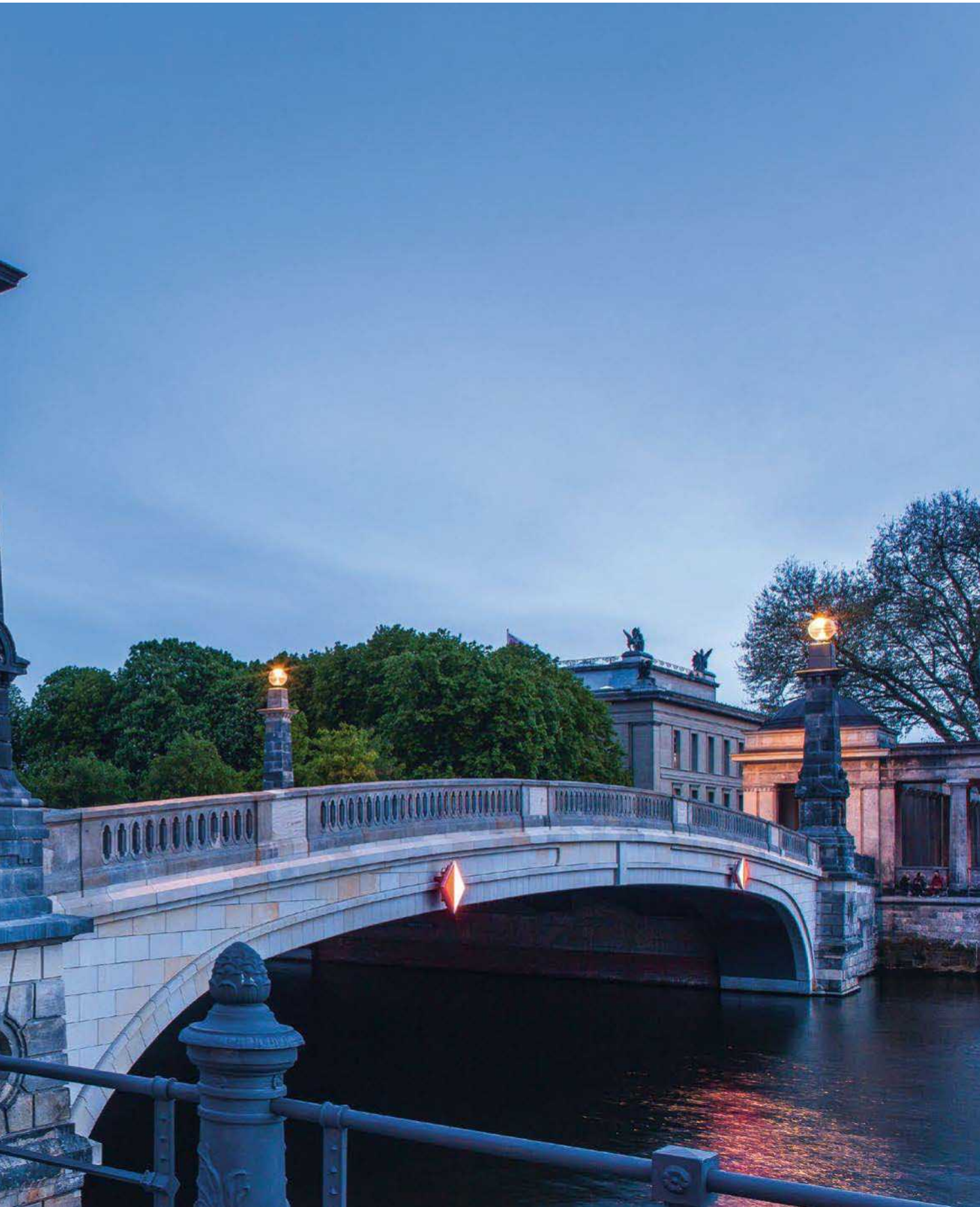
Surplombant la rivière Spree et l'île aux musées de Berlin, le Friedrichsbrücke est aujourd'hui l'un des endroits les plus romantiques de la ville pour les déclarations d'amour. Après la reconstruction et l'élargissement de ce pont classé, un nouvel éclairage a été installé sur ses obélisques de grès. Sur la base du contexte historique fourni par l'île aux musées, les quatre luminaires sphériques à LED baignent le Friedrichsbrücke d'une lumière agréable sans éblouissement pour les piétons ou les bateaux qui passent en dessous.
